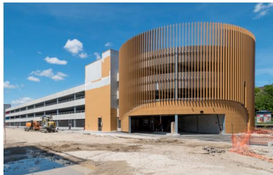
Nouveau parking relais, en construction
