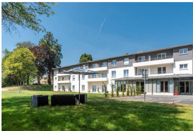
Source : EHPAD « Villa Beau Soleil», Cap résidence sénior.
