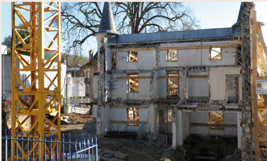
Chantier Lamazière au 6 novembre 2012 (Service communication)
